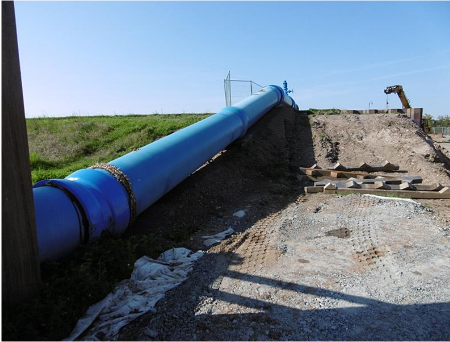
Paso de la tubería provisional DN 800 por el dique, entre el puente de tuberías que supera el río Mulde y la central abastecedora de Canitz
