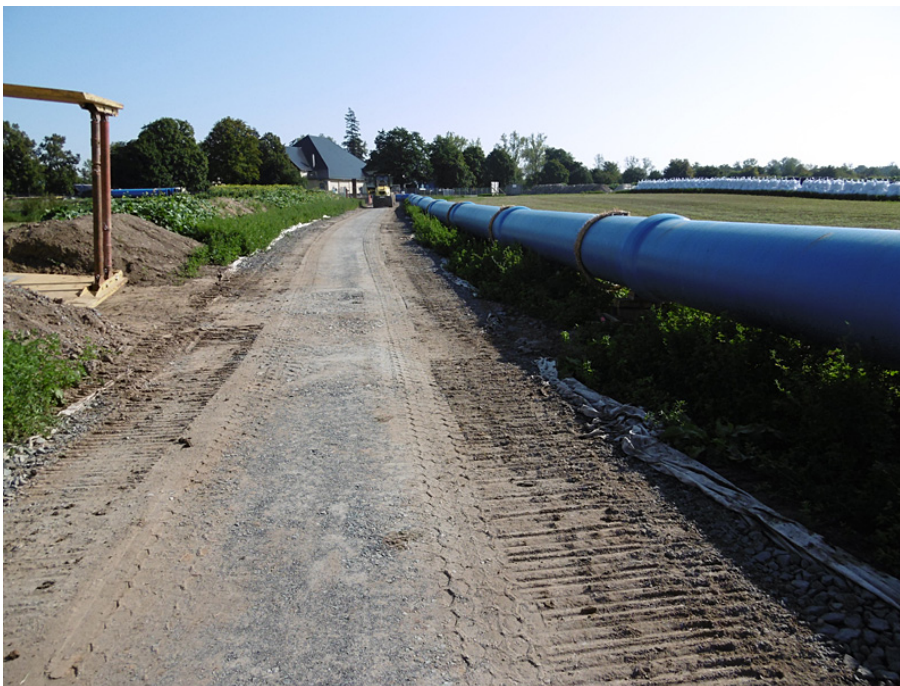
Geradliniger Verlauf der Interimsleitung entlang der Baustraße zum Wasserwerk Canitz
