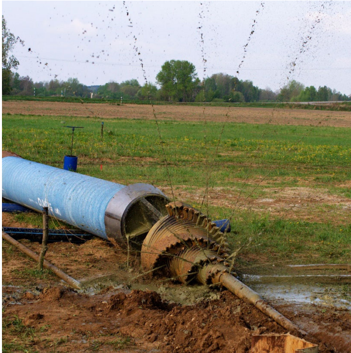
Prueba de funcionamiento del cabezal de perforación antes de introducir el tubo - Inserción del tubo en el orificio de perforación
