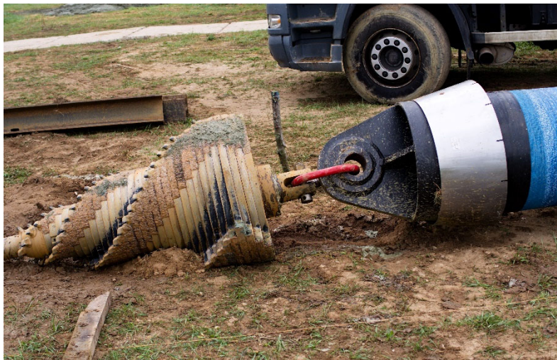
Conexión del cabezal de expansión y del cabezal de tracción del tubo DN 600
