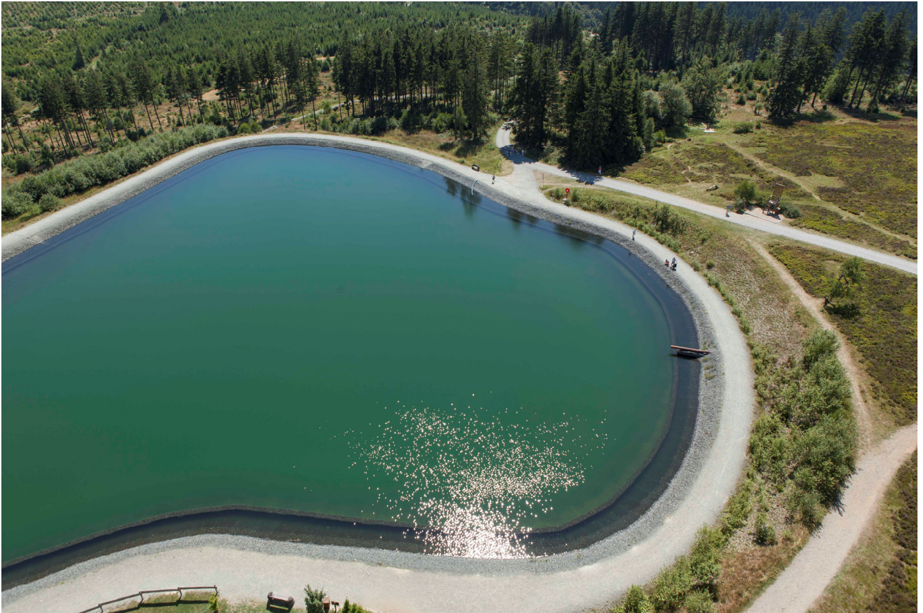
Vista sul bacino di accumulo, costruito già nel 2007
