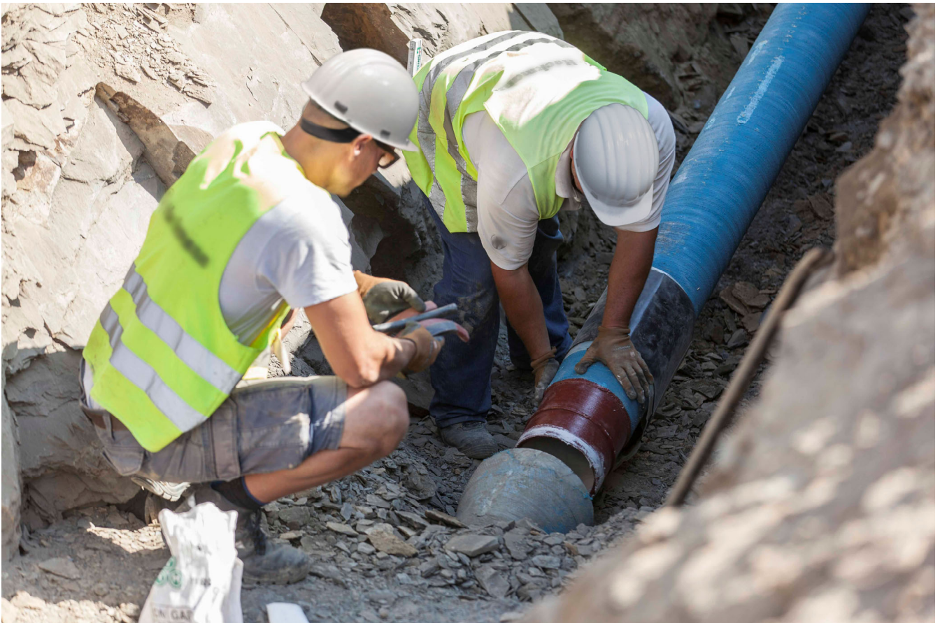
Posa dei tubi/montaggio nella trincea a cielo aperto
