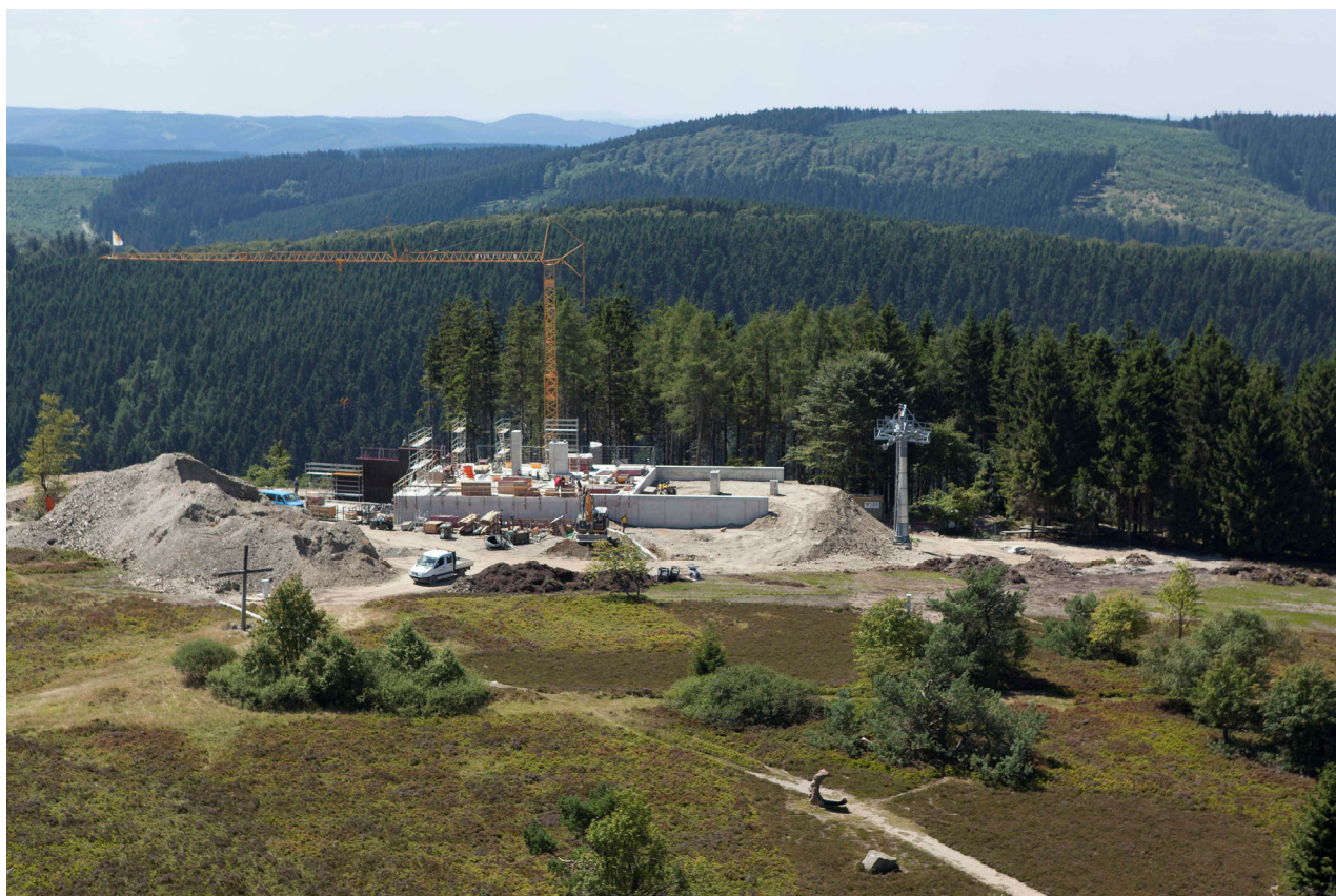
Nuova stazione a monte dell'impianto di risalita
