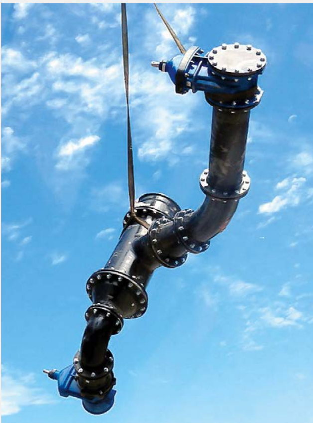
Fig. 10 Mit dem Helikopter eingeflogene vormontierte Seitenanschlüsse mit Schieber (Baugruppe).
