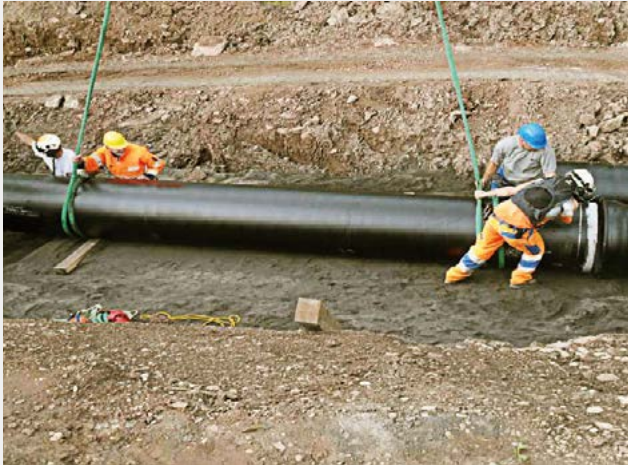
Fig. 9 Die duktilen Gussrohre vonRoll DUCPUR mussten zum Teil per Helikopter installiert werden.
