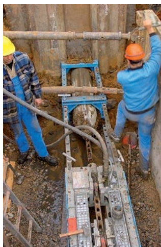
Posa di condotte senza scavo con tubi vonRoll ECOPUR.
