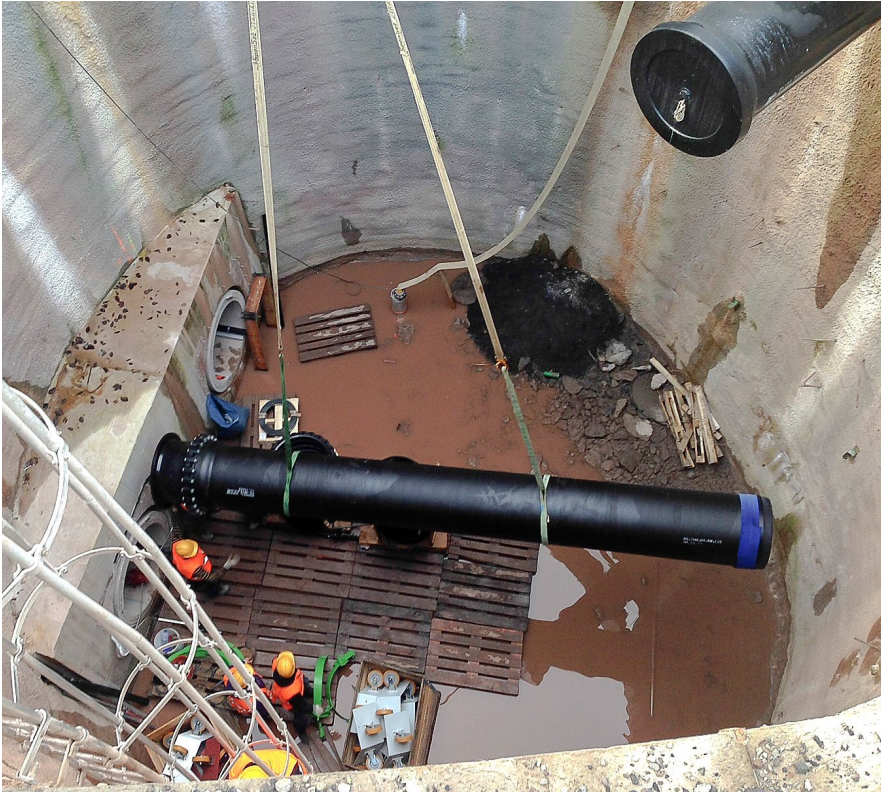
Doppelleitung DUCPUR DN 700 im Schacht, Einzug in Microtunnel aus Beton
