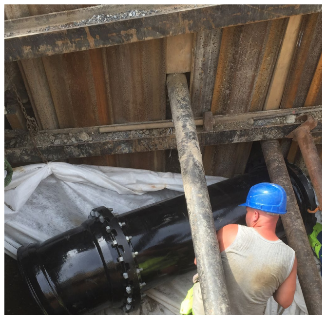
Montage DN 600 ECOPUR im gespriessten Graben
