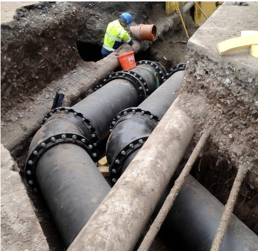
vonRoll DUCPUR, Doppelleitung mit Vor- und Rücklauf
